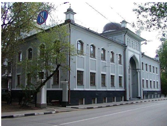
▪ Офисный центр ОАО «ЖАСО». Строительство нового и реконструкция старого здания.
