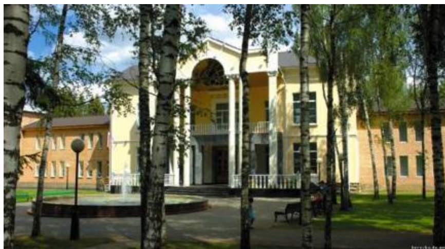
■ Дом отдыха «Березка». Капитальный ремонт здания.
