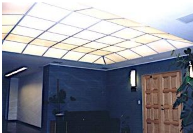
■ Главное управление ЦБ РФ по Томской обл. Новое строительство .
