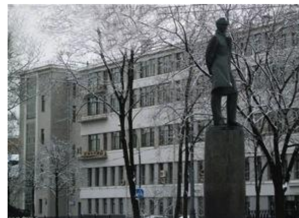
■ ОАО «РЖД». Реконструкция международной телефонной станции.
